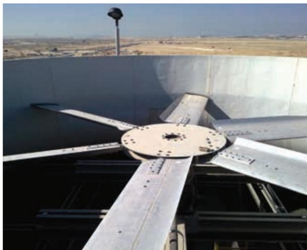
Figure 30: Aluminium fan inside fan stack
