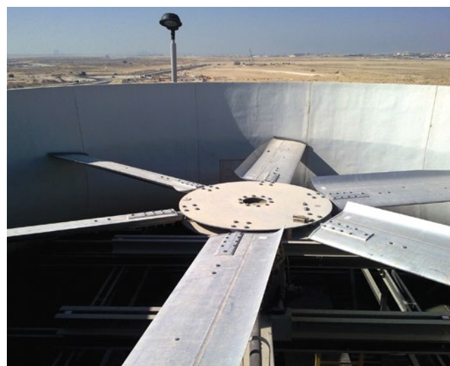
Figure 30: Aluminium fan inside fan stack
